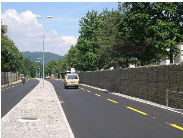
Lärmschutzwände aus Steingitterkörben mit Jurakalk-Füllung
