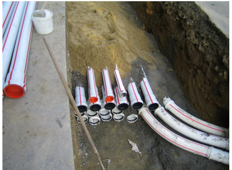
Neuer Kabelrohrblock in Engehaldestrasse
