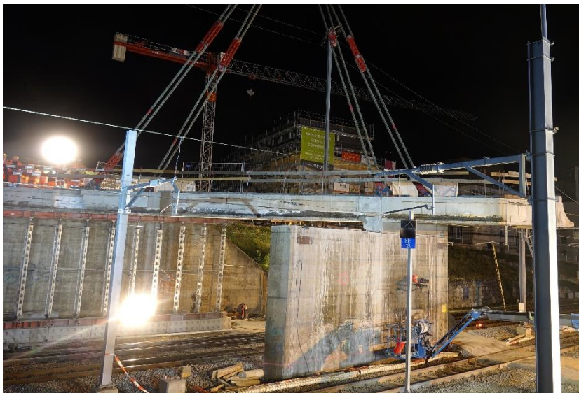
Abbrucharbeiten bestehende Überführung mit Raupenkran LR 1750/2 (Herbst 2019)
