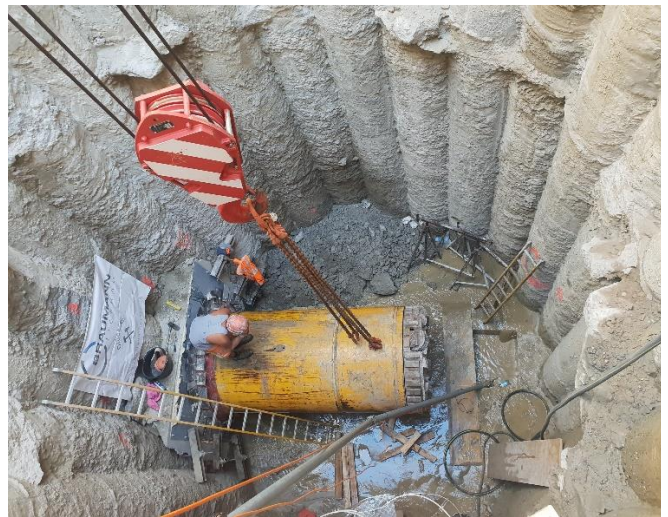
Bergung des Bohrkopfes aus dem Zielschacht (T = 15 m)
