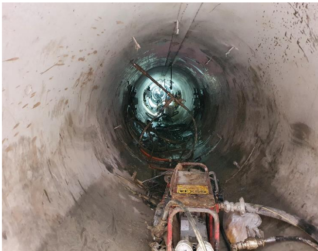
Erstellter Microtunnel beim Verpressen Ringspalt
