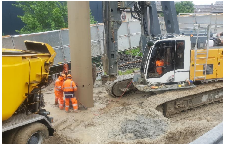
Erstellen überschnittene Bohrfahlwand DN 900
