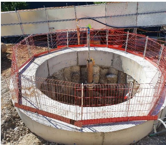
Aussteifungsriegel Zielschacht (Tiefe rund 15 m)
