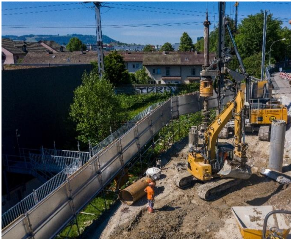
Erstellung Zielgrube unter engen Platzverhältnissen
